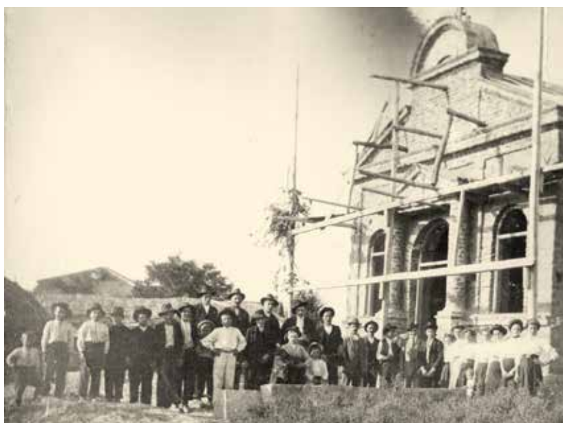
Biserica în construcție
