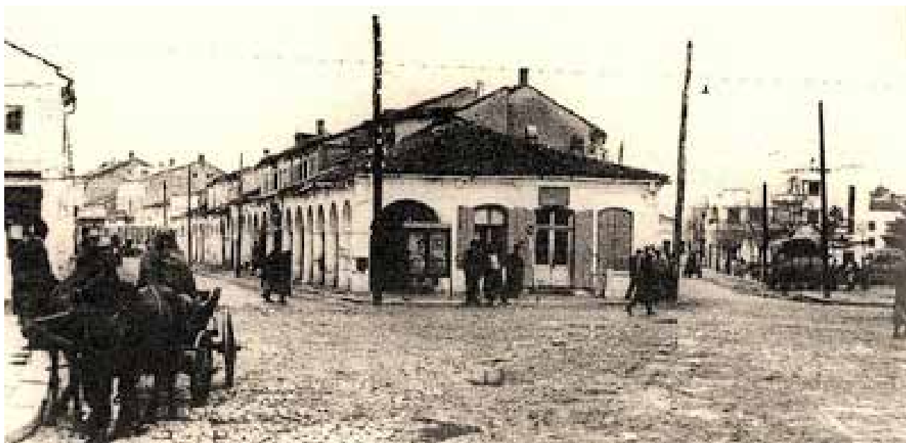
Vedere a coloanelor cu prăvălia de lumânări a lui Ivan Ivanov din intersecția străzilor Griviței, Basarabilor și Mahmudiei
