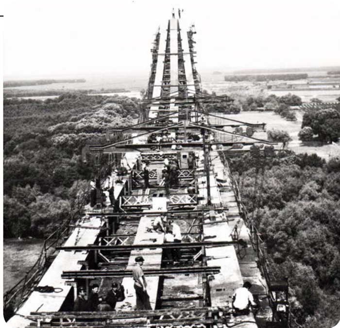
Grandiosul pod de la Cernavoda în timpul lucrului.
